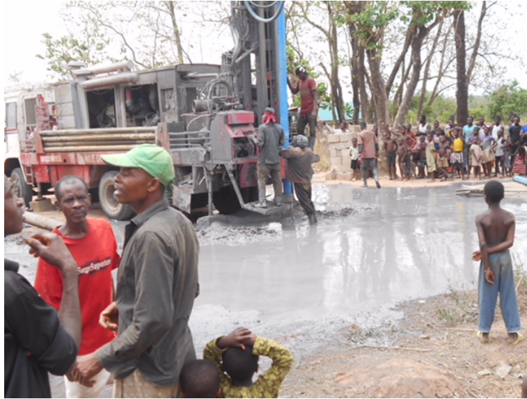
Forage du puits d'Ogbojwu (avril 2018)
